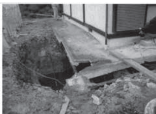
旧鉱物採掘区域災害復旧事業 震災により旧鉱物採掘区域が崩落し、家屋の下に陥没が発生
