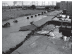
旧鉱物採掘区域災害復旧事業 震災により旧鉱物採掘区域が崩落し、家屋の下に陥没が発生
