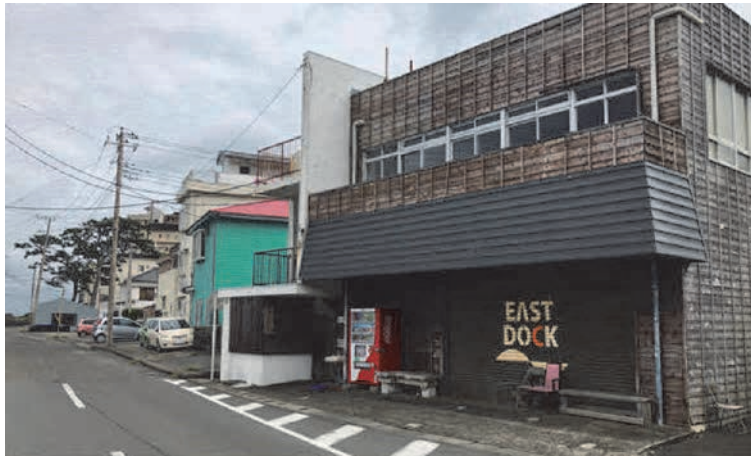
資料4 静岡県東伊豆町稲取のシェアスペース「EAST DOCK」 (小田撮影)
