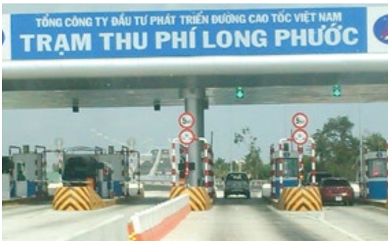
図2 ホーチミン—Long Thanh-Dau Giay 高速道路
