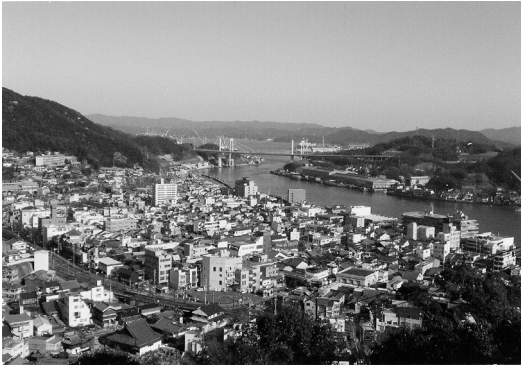
写真1 東の新尾道大橋方面
